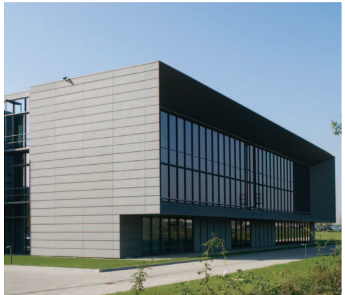
▲ Verwaltungsgebäude, Deutschland. Architekt : Christ & Christ. Kassetten.
