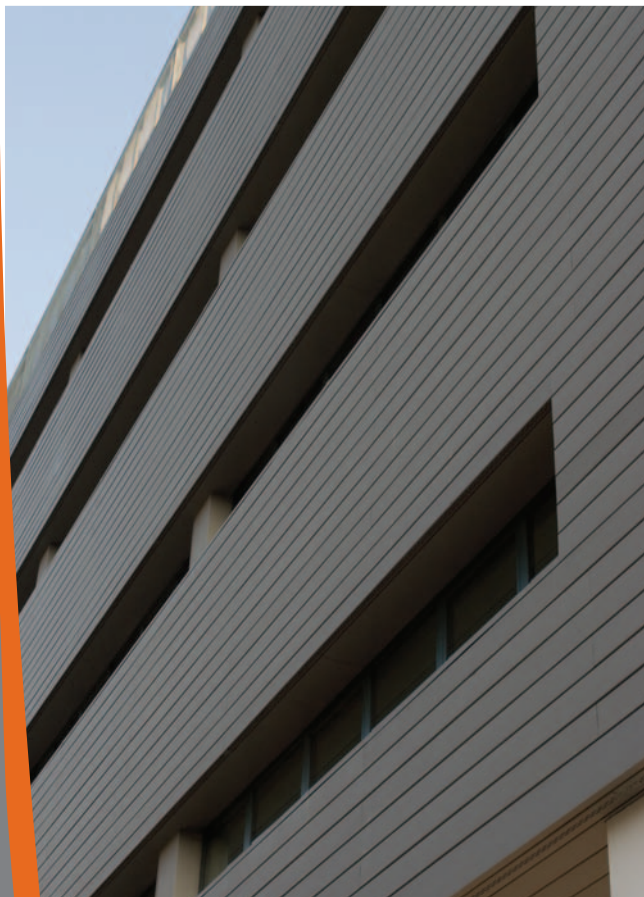
▲ Verwaltungsgebäude, Deutschland. Architekt : Dietz, Joppien. Steckfalzpaneel.
