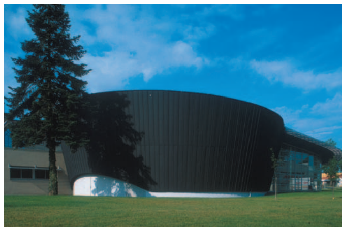
▲ Institut Supérieur de "Communication", Frankreich. Architekt : Pelleau und Michelot. Stehfalzsystem.
