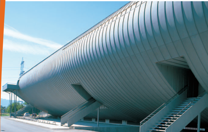
▼ Mehrzweckhalle, Österreich. Architekt : Kaufmann 96 GmbH. Stehfalzsystem.
